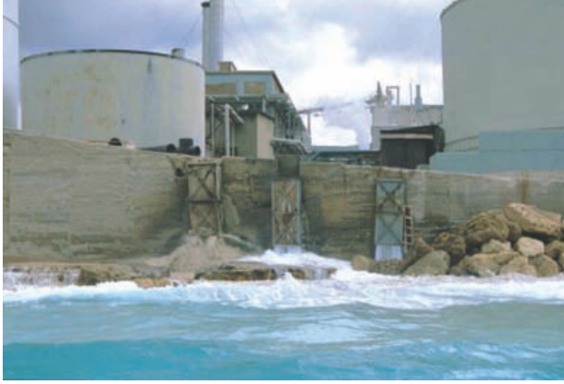
الصورة رقم 2.3: منشأة صناعية في شمال بترون بلبنان. يتم سكب حمض الكبريتيك مباشرة في البحر عند منشأة الفوسفات.
